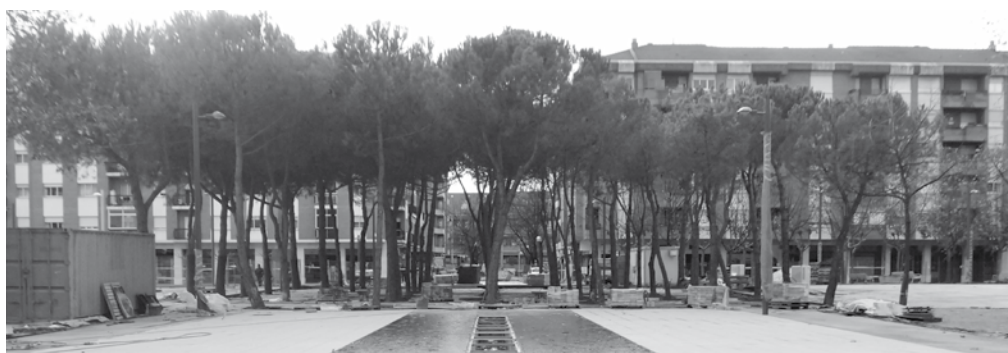
En estos momentos se trabaja en la pavimentación de la zona del 'bosque de pinos' y fuentes ornamentales
