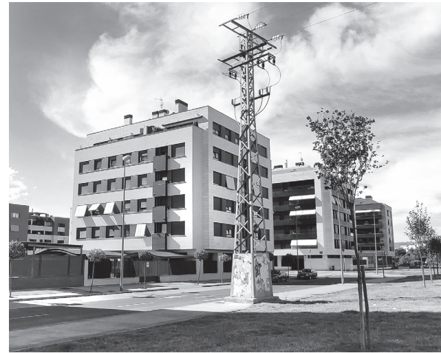
■ La línea eléctrica de media tensión que será soterrada en el parque Juan Gispert.
