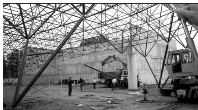
Construcción de Las Norias. Colocación de la estructura superior de la zona polideportiva cubierta, junto al frontón
