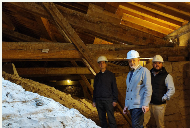
■ El alcalde visitó las obras de la torre de la iglesia de Santiago.
