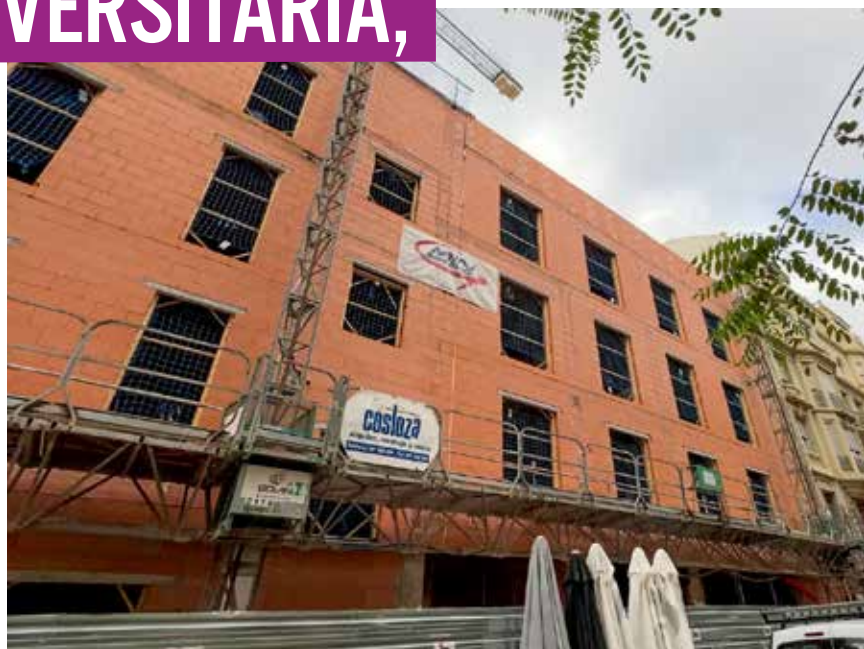
La nueva residencia finalizará sus obras en 2026.
