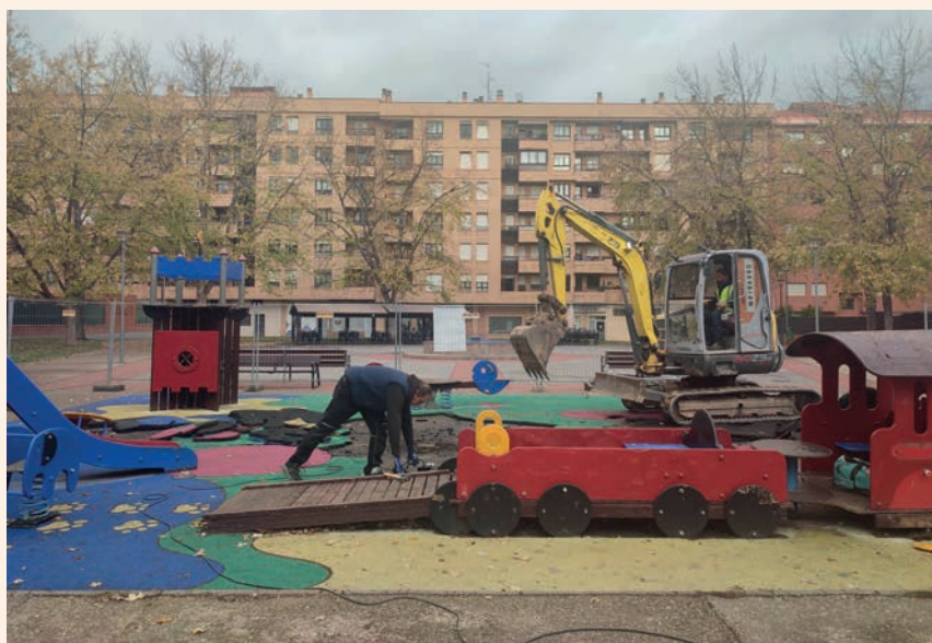
Las obras comenzaron el 24 de noviembre.
